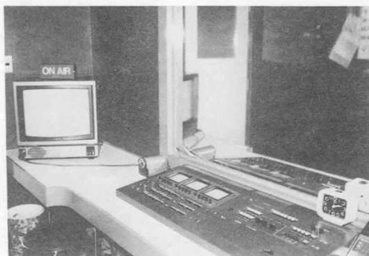
写真6 観察室に設置されたテレビカメラの遠隔操作装置とモニターテレビ（遠隔操作装置の下にビデオデッキが設置されている）
